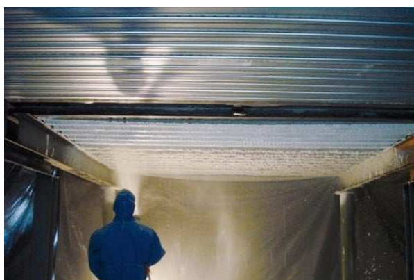
Detalhe de proteção conjunto laje/estrutura metálica
