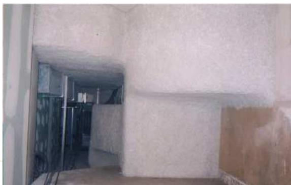
SERCWOOL F é um produto fibroso sem amianto destinado a proteção resistente ao fogo de condutas ventilação em chapa de aço, garantindo uma resistência ao fogo até EI 120 minutos.
