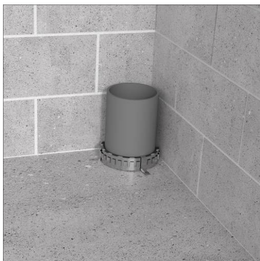
Aplicação em "C" na parte superior da laje
